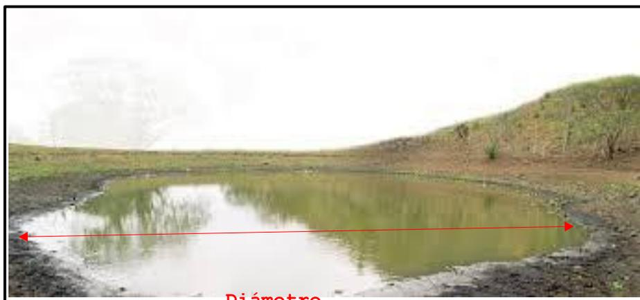
Figura 4. Diámetro de una obra de cosecha de agua circular.
